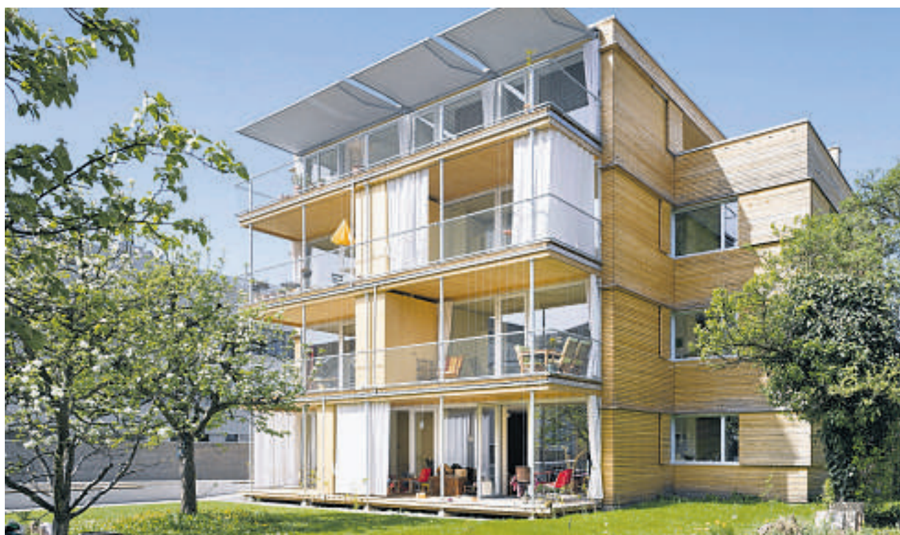
Vorteil des Holzelementbaus: Nach nur vier Tagen stand das Gerüst des Mehrfamilienhauses im Zentrum von Aarau.
